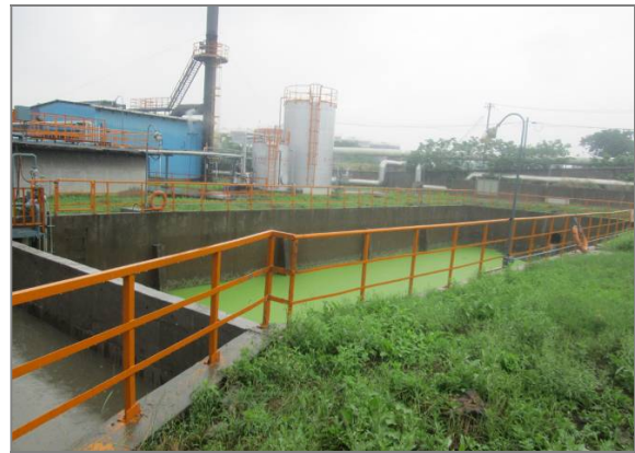
废水事故应急池
